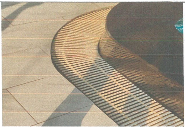
รูปที่ 3-32 รางระบายน้ำสันมีฝาปิดรอบสระว่ายน้ำ
