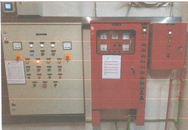
รูปที่ 3-41 ระบบมิเตอร์ไฟฟ้าสำหรับห้องเครื่องสูบน้ำ ดับเพลิง
