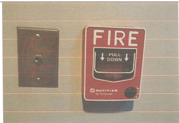
รูปที่ 3-42 เครื่องแจ้งเหตุโดยใช่มือดึง (Manual Station)
