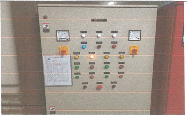
รูปที่ 3-17 ระบบมิเตอร์ไฟฟ้า สำหรับสูบน้ำภายในอาคาร
