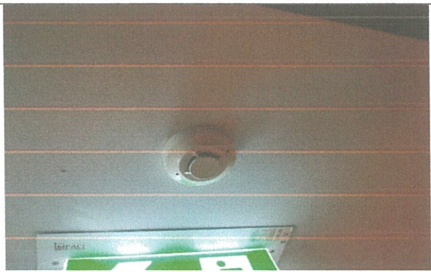
รูปที่ 3-48 เครื่องตรวจจับควัน (Smoke Detector)
